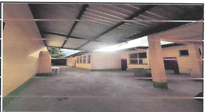
Foto 10: Pintura en muros exteriores e interiores.
