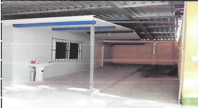
Foto1: Colocación de drenajes para salida de pluvial.
