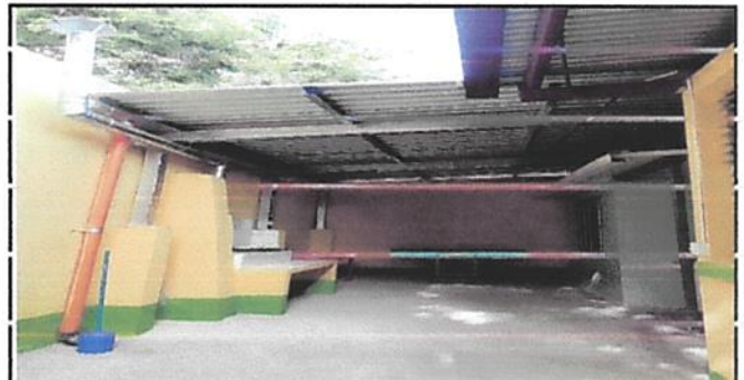
Foto 6: Techado lateral a cocina.
