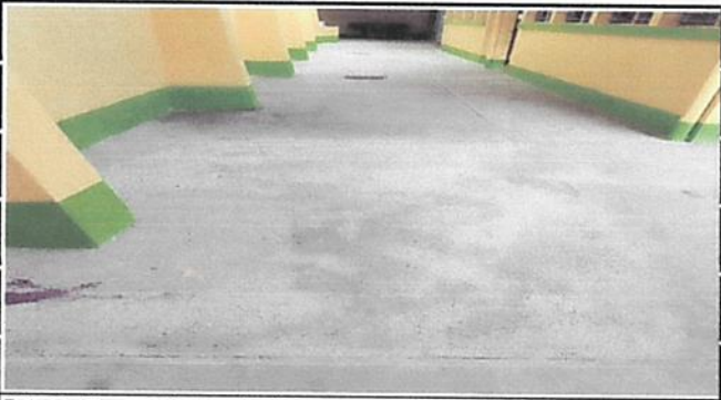
Foto 9: Reparacion de plancha.
