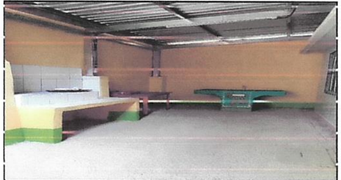
Foto 2: Colocación de torta de cemento.
